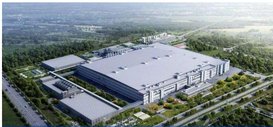
長沙惠科光電有限公司- 第 8.6代超高清新型顯示器件生產線項目潔淨包1工程 電力二次配工程
