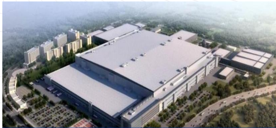
綿陽惠科光電科技有限公司- 第8.6代薄膜晶體管液晶顯示器件項目潔淨包1工程
