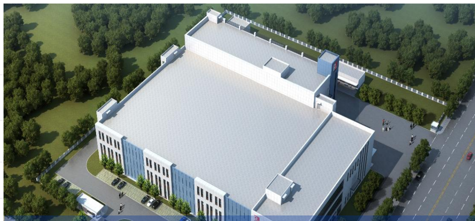
合肥豐創光罩有限公司 - 10.5代廠新建專案機電統包工程
