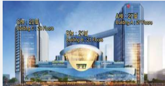
台灣人壽C3新建工程-機電工程
