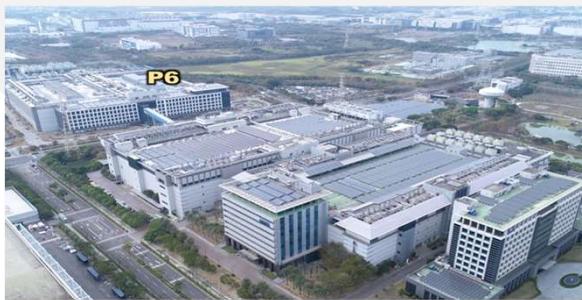
聯華電子(股)公司 FAB12A P6 無塵室+MEP統包工程
