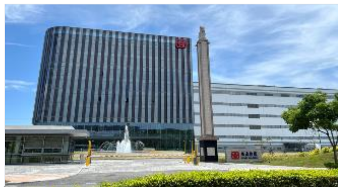
鵬鼎科技高雄園區建置工程
